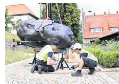
Haviland hat die Bronze mit Stützen gesichert, um drei Stahlgewinde anbringen zu können.
